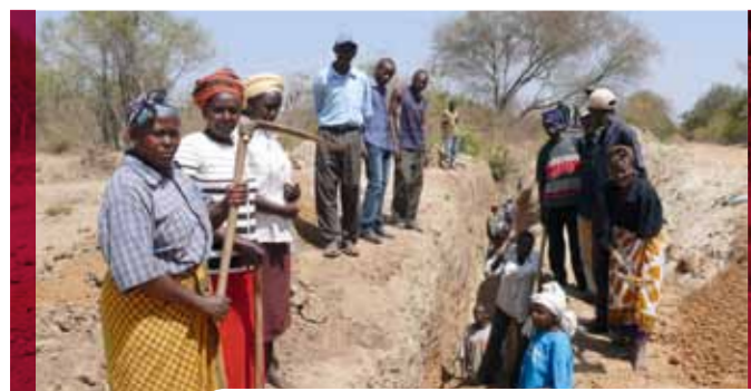
Das Ausheben eines Kanals – mühsame Handarbeit bei sengender Hitze.
